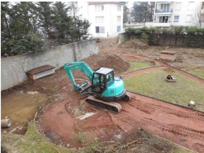
Toute la terre qui recouvrait les locaux du sous-sol a été retirée dans l'objectif de creuser des puits de lumière et de préparer la dalle pour la nouvelle construction à venir.
